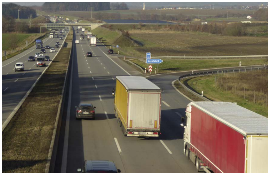
Bild 1: Moderne Betondecken bieten höchsten Fahrkomfort. Fugen sind nicht mehr zu spüren (Autobahn A8 bei München).
