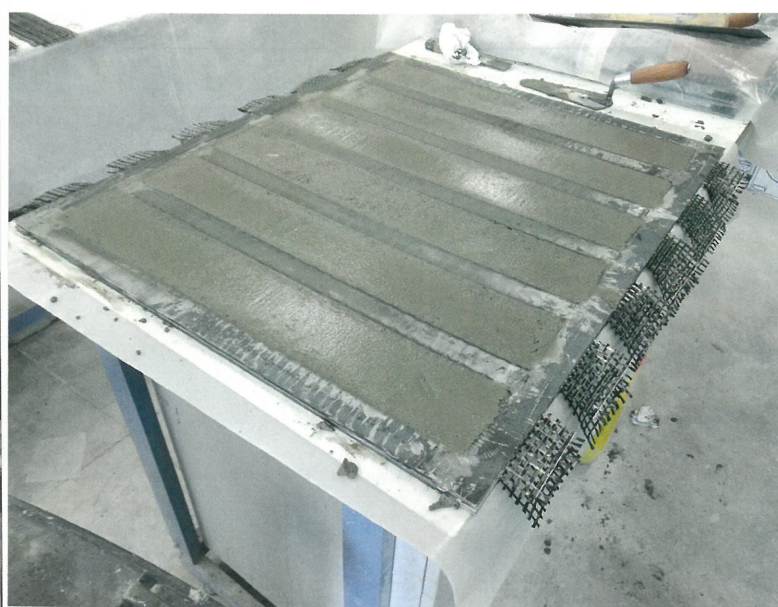
Abb. 4: Entwicklung von auf AAM basierendem Textilbeton für die konstruktive Sanierung von Beton (Foto bereitgestellt von A. Arce) [9]
